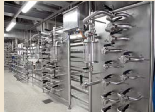
Bei den Ein- und Austrittspaneelel wurde die halbautomatische Ausführung gewählt – sind die Schwenkbögen eingelegt, laufen alle weiteren Prozesse automatisch ab
