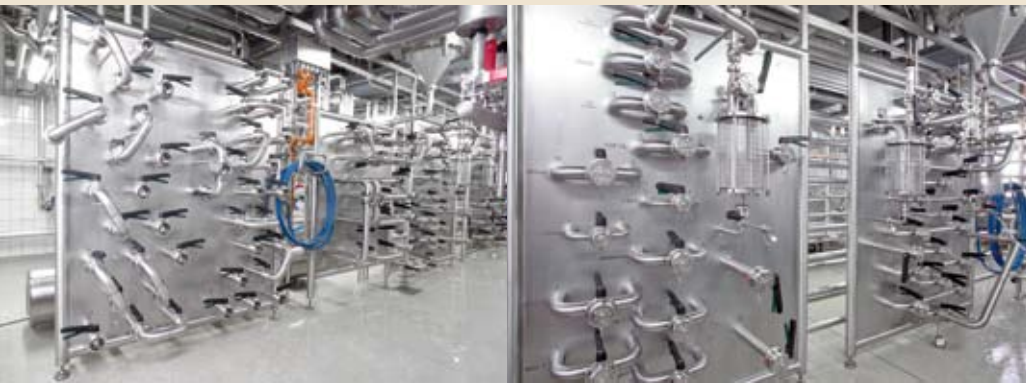
Bei den Ein- und Austrittspaneelel wurde die halbautomatische Ausführung gewählt – sind die Schwenkbögen eingelegt, laufen alle weiteren Prozesse automatisch ab
